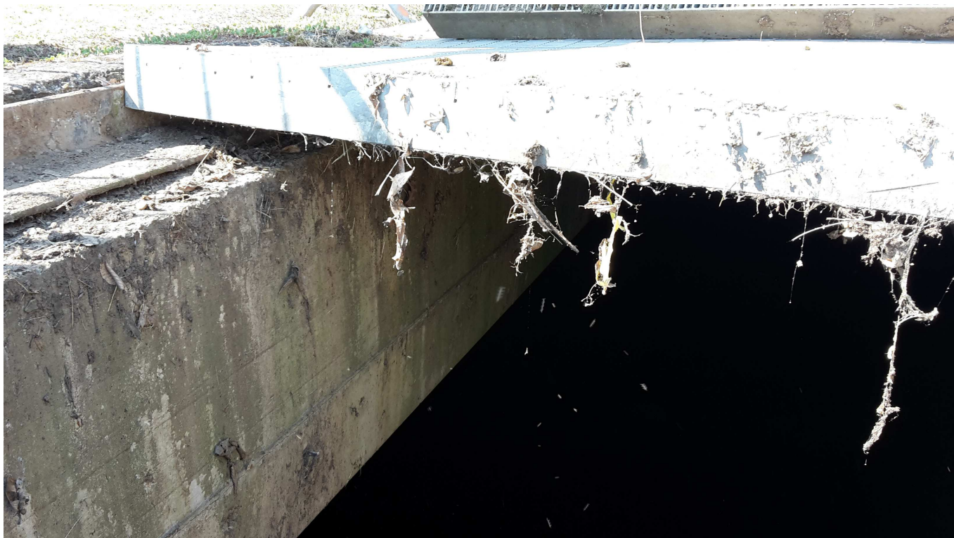
Foto n°2 – fianco trave prefabbricata a T, lato sinistro
