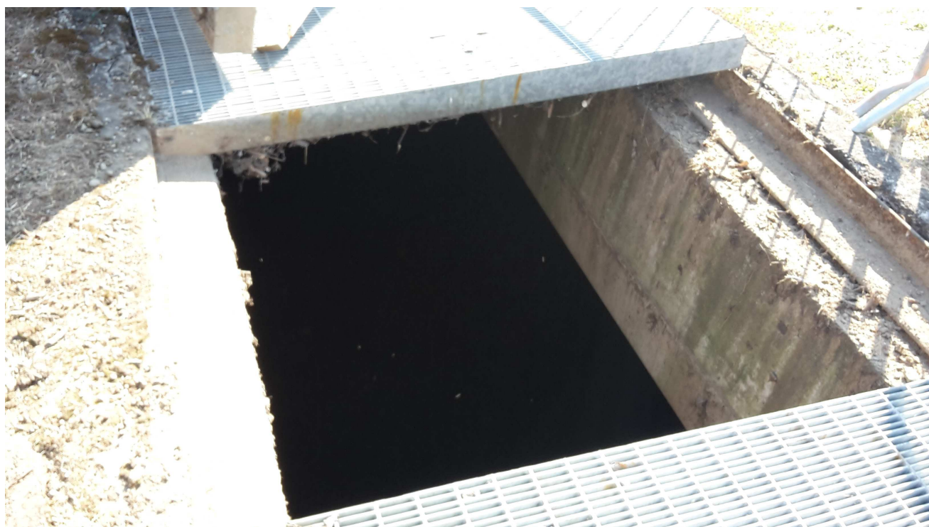
Foto n°4 – Vista dall'alto zona delle griglie ove è avvenuta la traslazione, e si evince l'integrità delle travi
